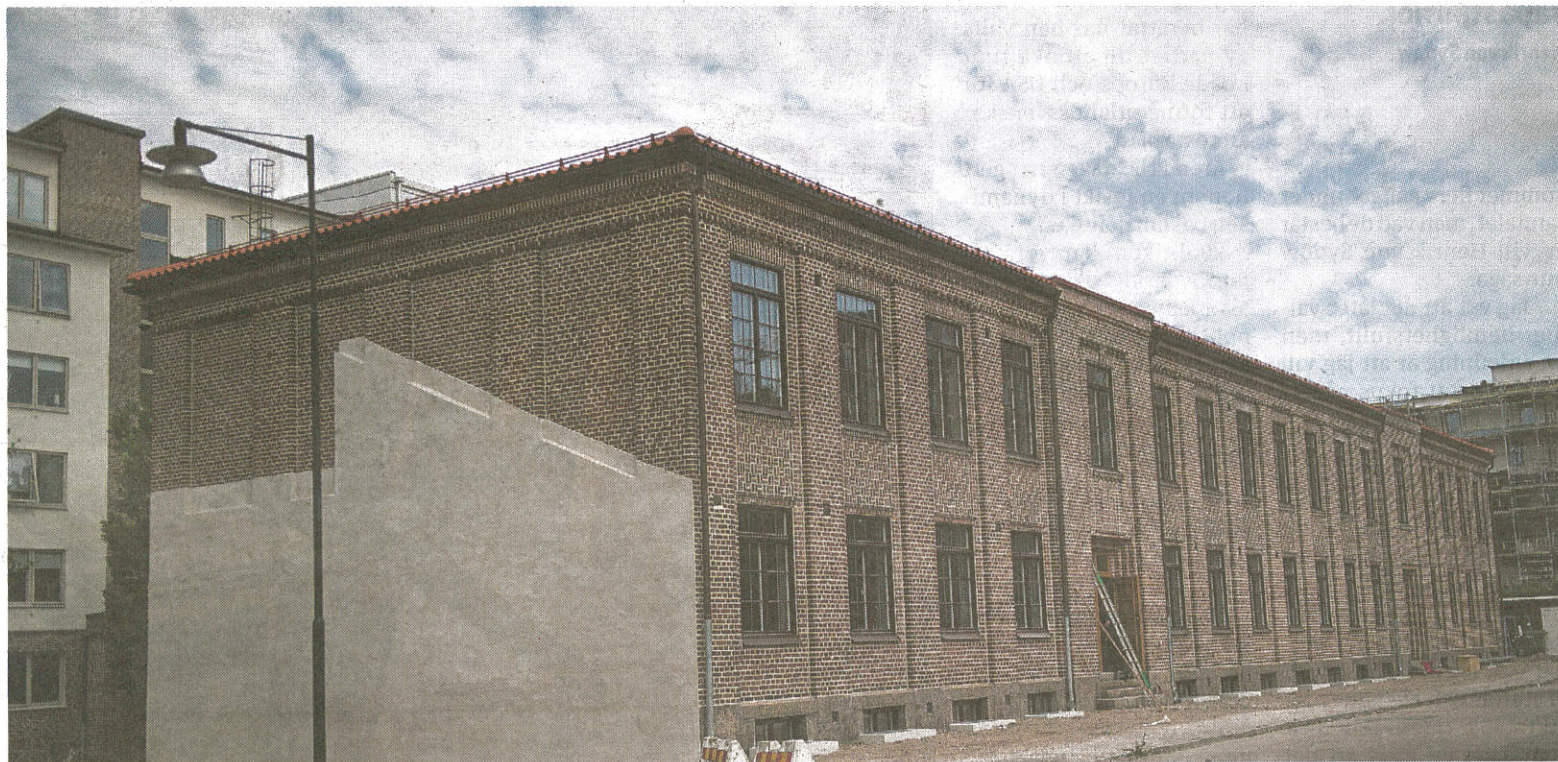
INGEN SKAMFLÄCK. Under många år har boende oroats över kontorsbyggnadens förfall, nu är den i skick som när den byggdes.
